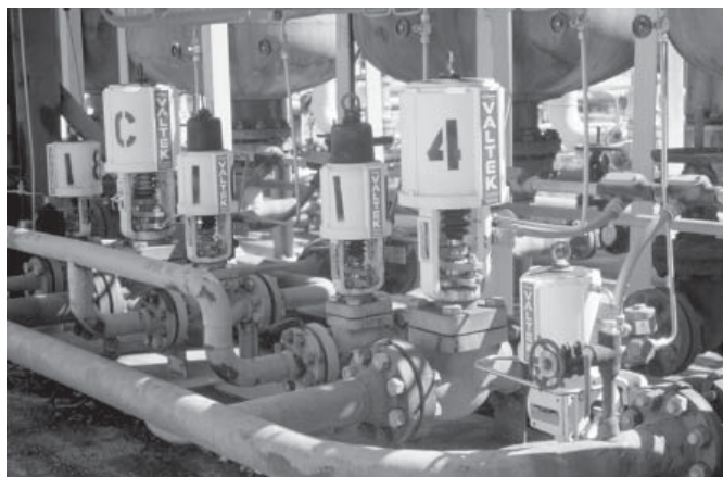
Этот клапан Mark One в низкотемпературном исполнении установлен в качестве дренажного клапана на линии подачи кислорода в оборудовании для изучения воздушно-космического пространства
